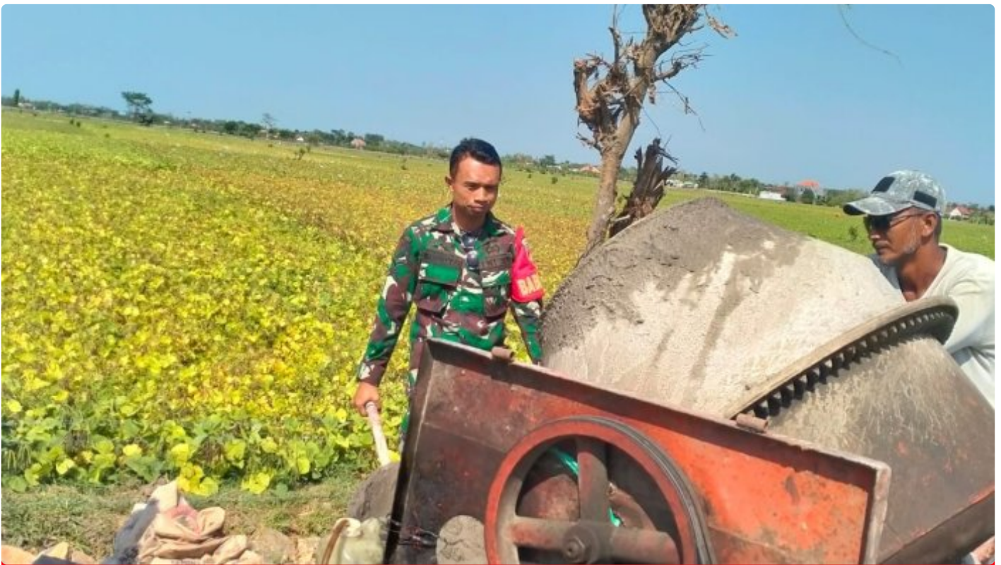
TNI Selalu Hadir Ditengah Rakyat, Babinsa Bantu Warga Buat Talud
